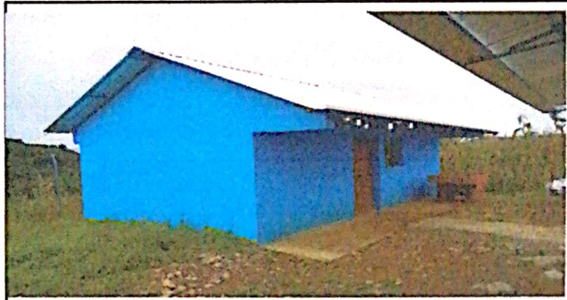
Foto 4: terminado la ampliacion de la cocina
