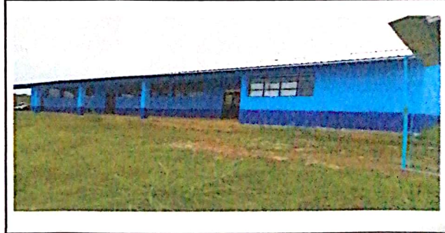
Foto 6: culminacion de ampliacion del centro Educativo
