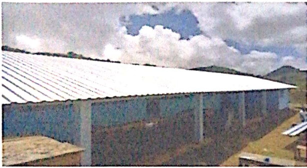
Foto1: cambio del en techado, terminado
