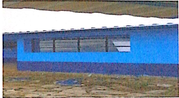
Foto 2: cambios de ventana del establecimiento, terminado
